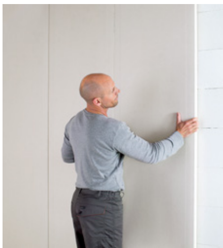
▲ Muurisolatie aan de binnenkant (Beeld: Recticel Insulation)
